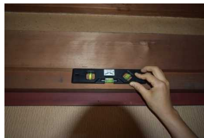
写真 9. 傾きを測定している様子
