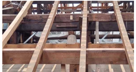
写真 18. 鉄骨による補強
