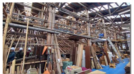
写真 16. 作業現場の様子
